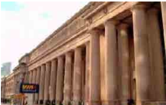
● شکل ۳۶: ساختمان رویال یورک که توسط شاخه‌های اولیه زیرزمینی پت در سال ۱۹۲۷ به ایستگاه یونیون متصل شد.
