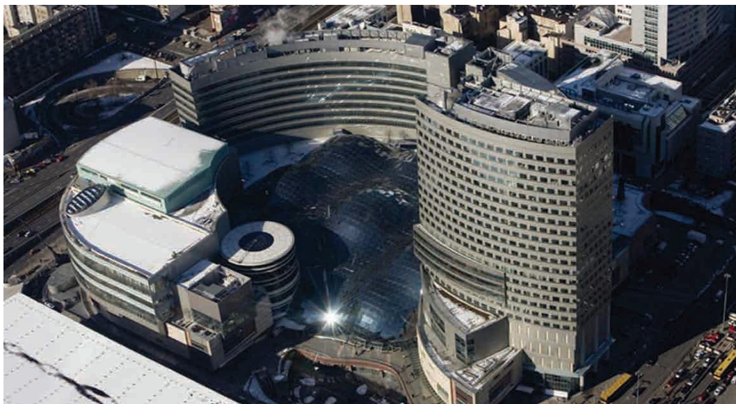
● شکل ۱. نمای کلی از مجموعه تراس‌های طلائی و ساختمان‌های اداری-تجاری آن
