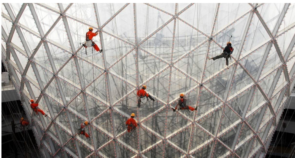
● شکل ۴: شیوه گران و پرخطر نظافت و تعمیرات در سطوح خارجی برج‌ها و مجتمع‌های بلندمرتبه فاقد کلاچمر
