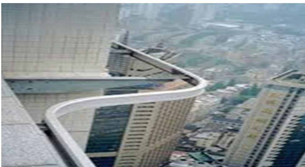
● شکل ۳: مکانیزم مونورييل برای نصب کلايمر
