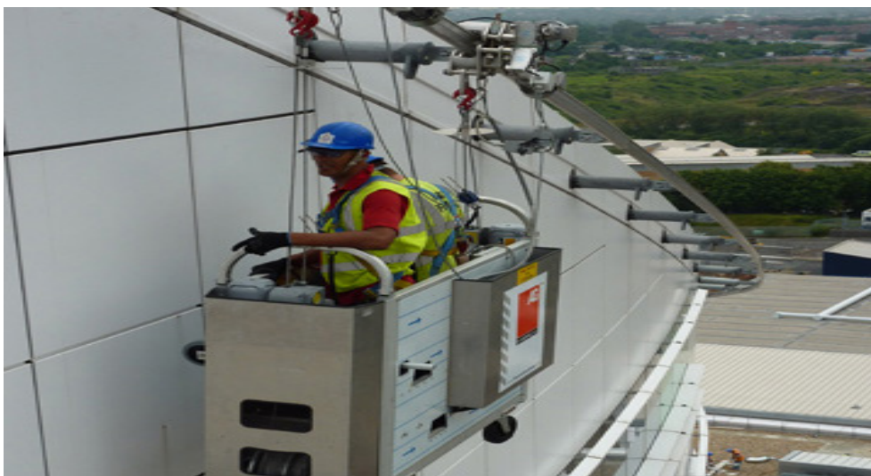
● شکل ۲: کلايمر مونورييل نصب شده بر پيشاني نماي بنا
